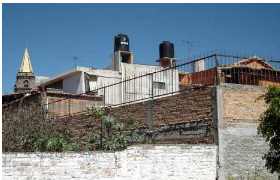
Réservoirs d'eau chaude sur les toits
